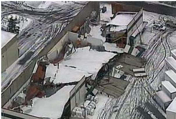
Üzemi épületek beszakadt tetőszerkezetei [1]
